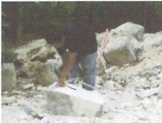
Foto No. 3, vista del corte y tallado de la piedra para sillares
