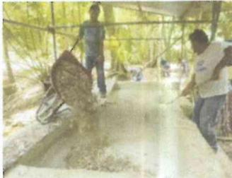
Foto No. , Vista de la elaboración de concreto caliza para fundir la terraza
